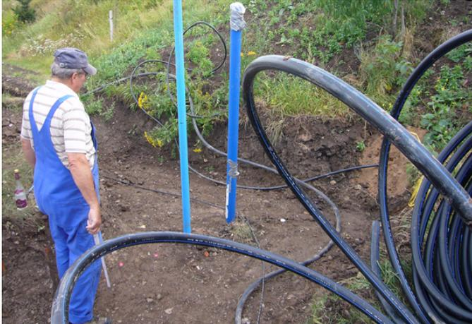
Unsere Motocross-Anlage erhält eine weitere Aufwertung. Nachdem die Wasserleitung vom Brunnen am Seegraben bis zum Motorsportgelände verlegt ist, sind die Motorsportler des MSC Gräfentonna e.V. in vielen Arbeitseinsätzen dabei, die Bewässerungsanlage der Rennstrecke zu verlegen. Ein Zuleitungskabel zur Pumpenleitung und der Übergabepunkt Wasserleitung - Pufferbehälter wurde bereits installiert.
